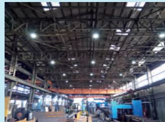
某鋼構造物製作メーカー様
